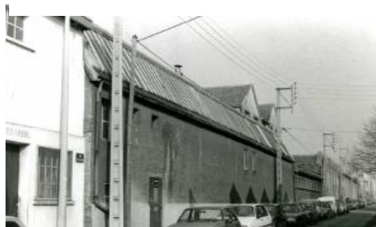
Figure 13 : Etat d'origine - Vue depuis la rue Brulard, Service de l'Inventaire Général du Patrimoine Culturel.
