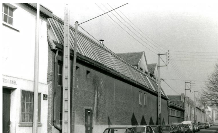
Etat d'origine - Vue depuis la rue Brulard
