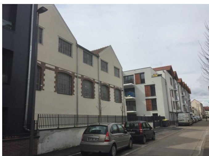
Etat actuel - Vue depuis la rue Brulard
