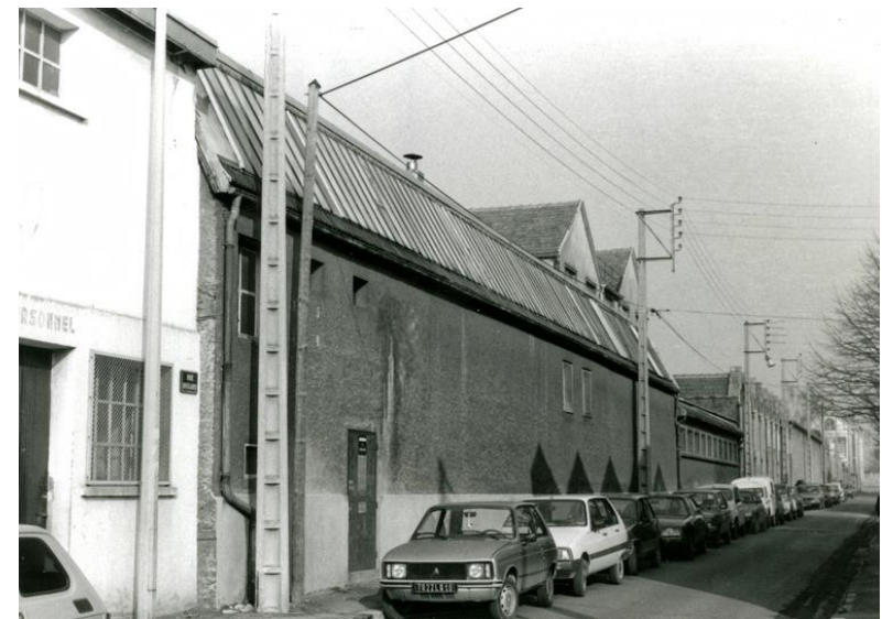
Etat d'origine - Vue depuis la rue Brulard
