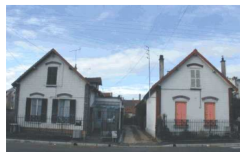
Maison ouvrière (lotissement)
