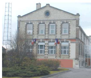
Bâtiment d'usine (caserne de pompiers)
