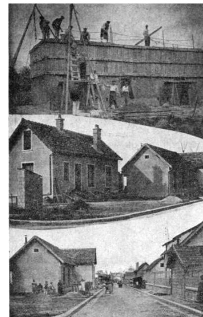
Cottage Social de Troyes. — La rue Edmé-Millard en construction: 1920.
