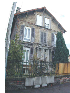
maison ouvrière collective
