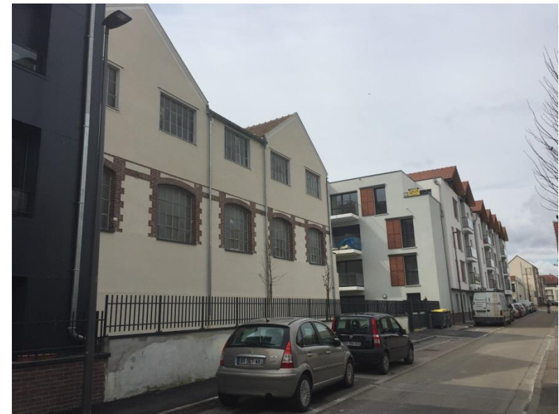
Etat actuel - Vue depuis la rue Brulard
