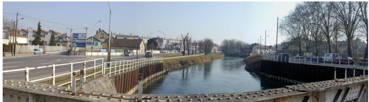
Du pont de la rue Kléber vers le sud
